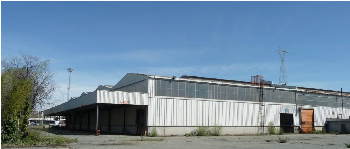
Figura 9 - UMIA1b – porzione Capannone ex Gommatura - vista esterna
