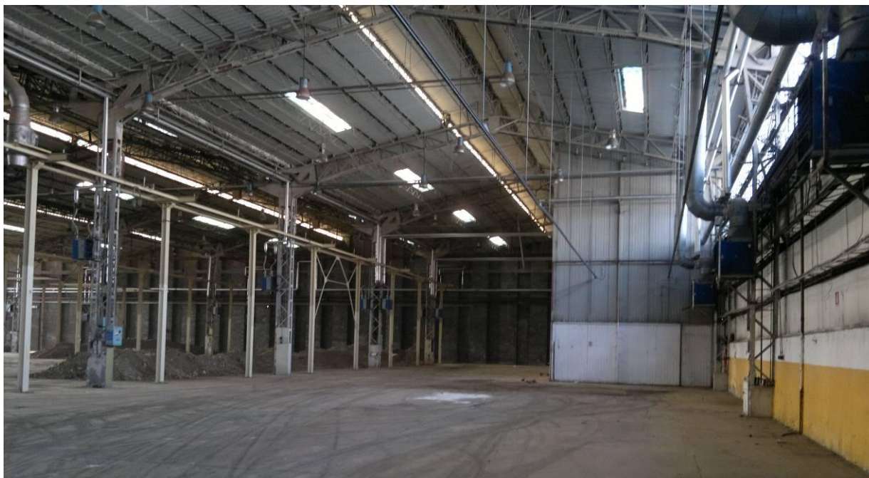
Figura 10 - UMIA1b – porzione Capannone ex Gommatura - vista interna
