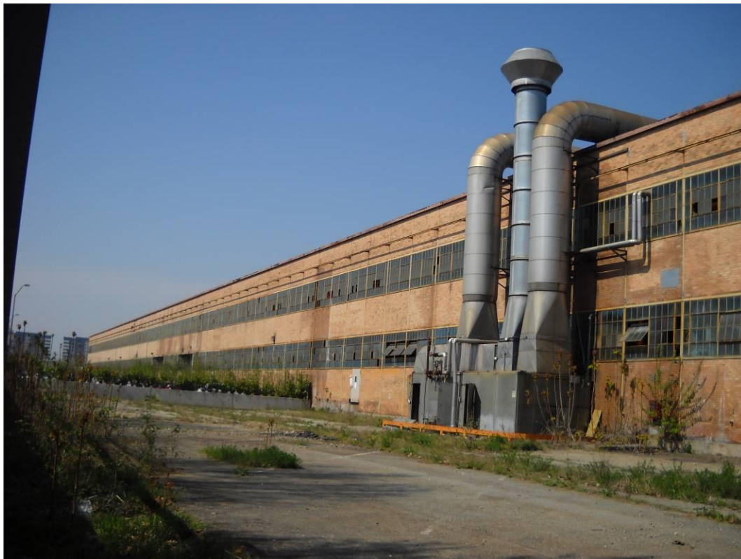
Figura 2 - UMIA2 – porzione Capannone ex DAI - vista esterna
